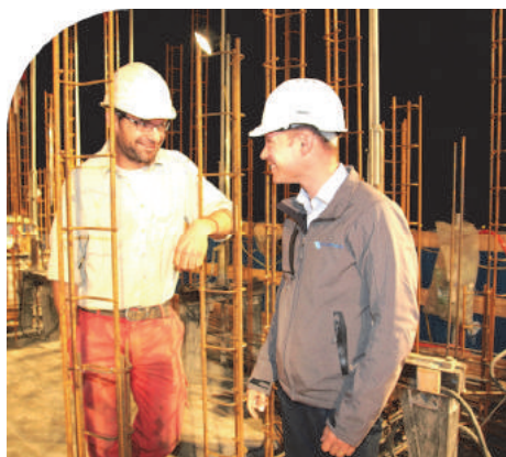
Ingenieur Martin Heller (rechts) unterhält sich bei seiner Baustellenkontrolle mit Polier Simon Herburger
