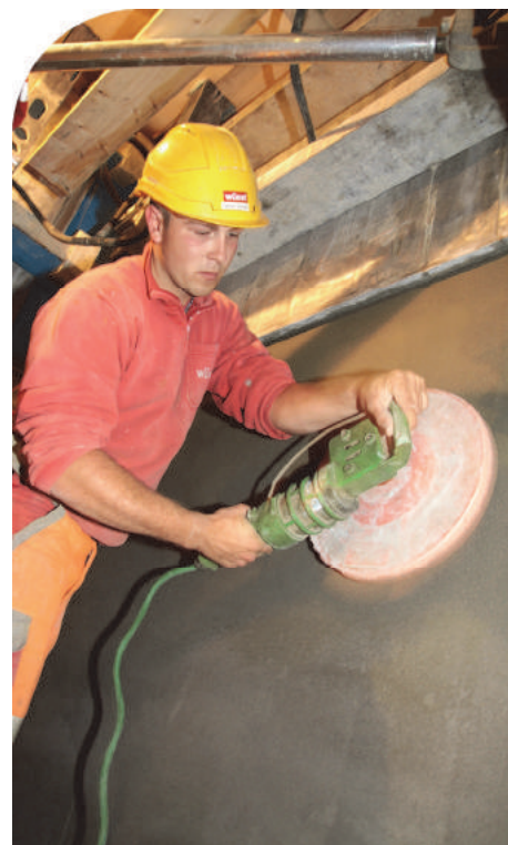
Nachts um zwei Uhr sorgt Maurer Dominik Geiser mit der Abriebmaschine für glatte Silowände
