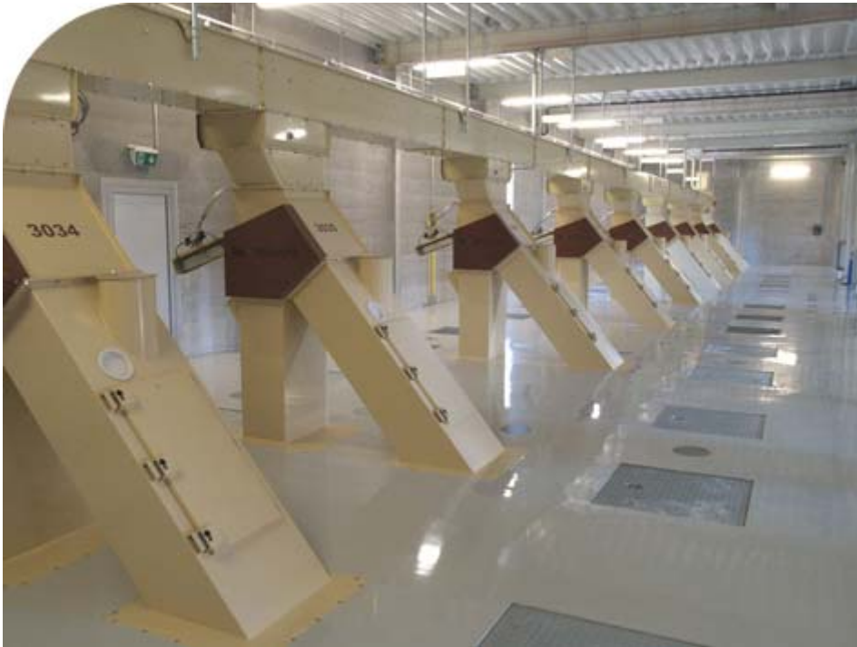
Verteilboden im obersten Stock des Silos
