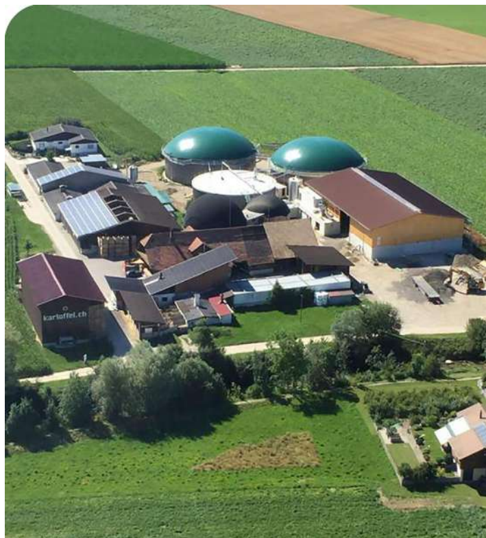
Der Getreideabgang der Egli-Mühlen AG wird in der Biogasanlage Altishofen nachhaltig wiederverwertet.
